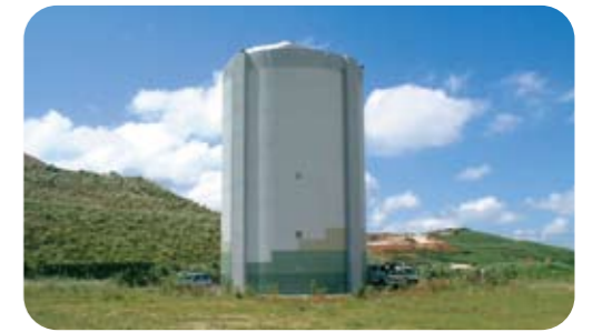
平尾台配水池 (小倉南区)
