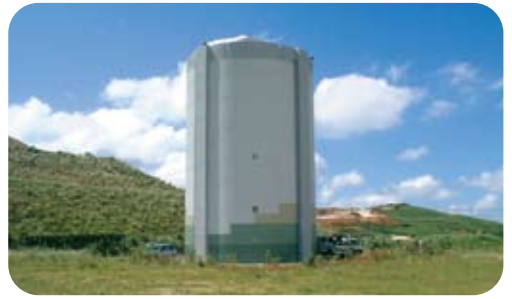
平尾台配水池 (小倉南区)
