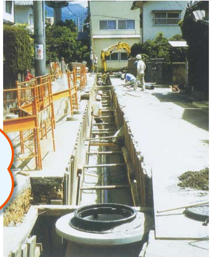
道路をほって、下水管をうめる。(小さな下水管)
