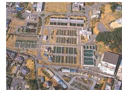
穴生浄水場 (昭和36年完成)
