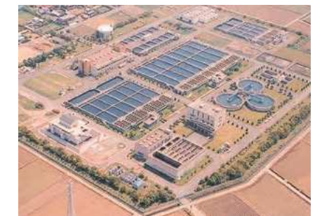
本城浄水場 (昭和58年完成)
