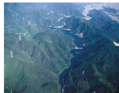
ます淵貯水池 (昭和48年完成)
