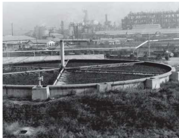
皇后崎下水処理場の散水濾床
