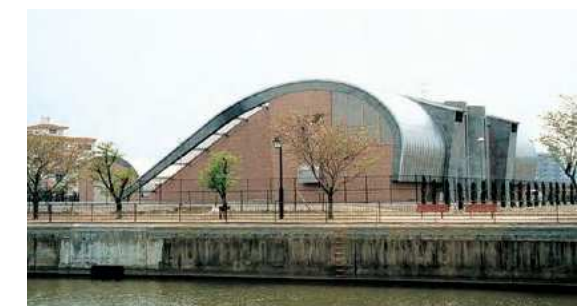
金山川ポンプ場
