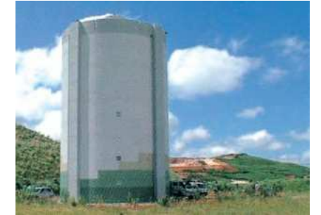
平尾台配水池
