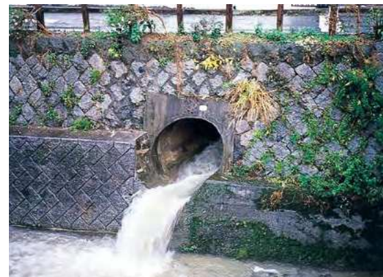
雨天時の合流式下水道の雨水吐の様子(板櫃川)
