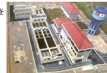
カンボット市上水道拡張事業 浄水場竣工
