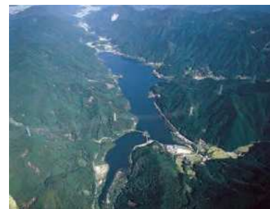
油木貯水池 (昭和46年完成)
