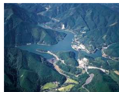
力丸貯水池 (昭和40年完成)
