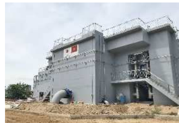
アンズオン浄水場改善計画で整備された U-BCF(上向流式生物接触槽)
