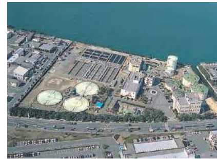
新町浄化センター（門司区）
