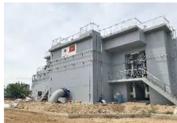
アンズオン浄水場改善計画で整備された U-BCF(上向流式生物接触槽)
