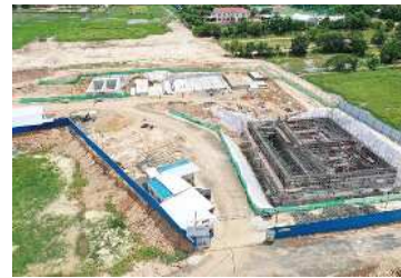
コンボントム上水道拡張事業 浄水場施工
