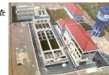
カンボット上水道拡張事業 浄水場竣工
