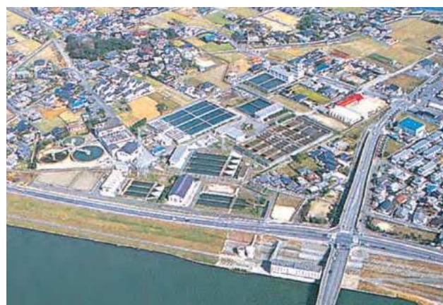
伊佐座取水場(昭和19年完成)
