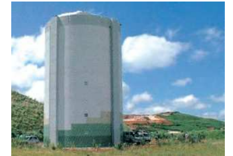
平尾台配水池
