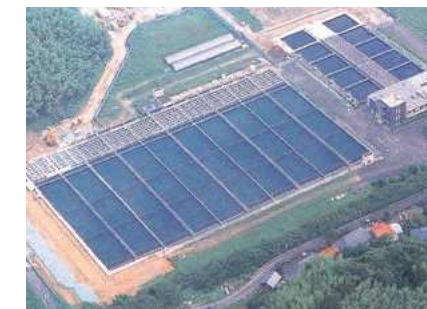
井手浦浄水場 (昭和47年完成)
