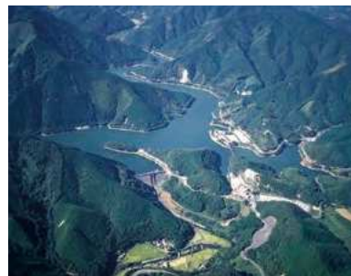
力丸貯水池 (昭和40年完成)
