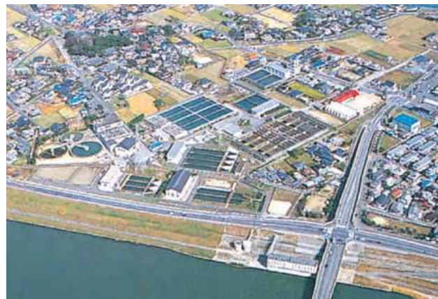
伊佐座取水場 (昭和19年完成)
