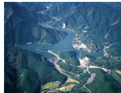
力丸貯水池 (昭和40年完成)
