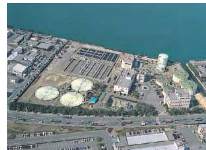
新町浄化センター(門司区)
