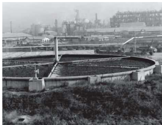
皇后崎下水処理場の散水濾床
