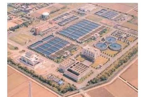
本城浄水場 (昭和58年完成)
