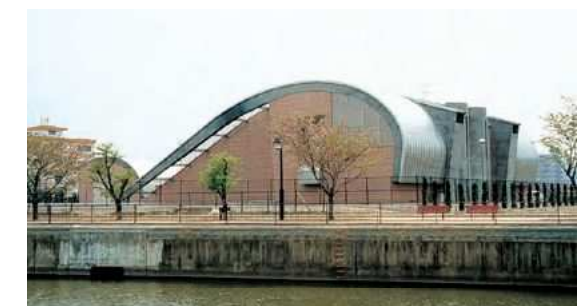
金山川ポンプ場
