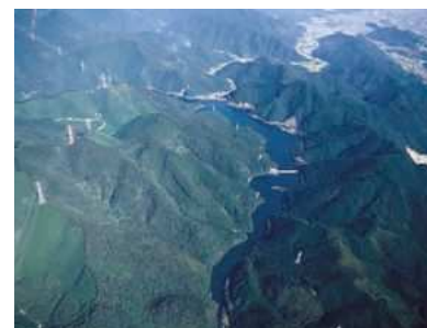
ます淵貯水池 (昭和48年完成)
