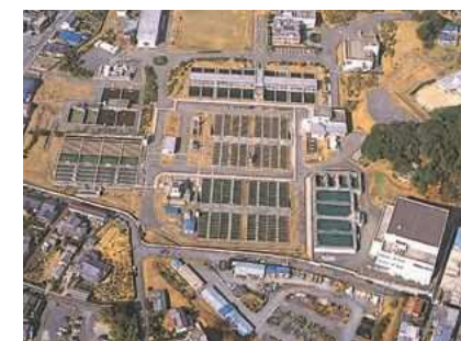
穴生浄水場 (昭和36年完成)
