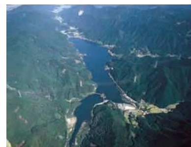
油木貯水池 (昭和46年完成)
