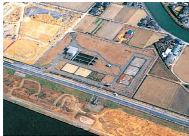
猪熊取水場 (昭和58年完成)
