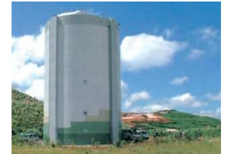
平尾台配水池
