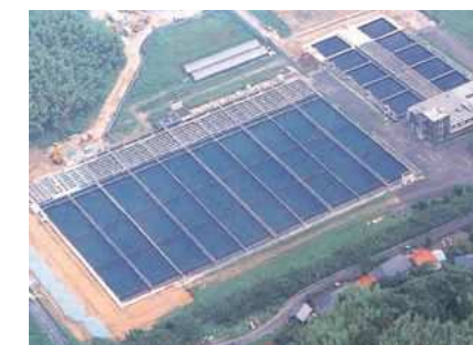
井手浦浄水場 (昭和47年完成)
