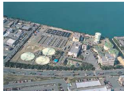
新町浄化センター（門司区）
