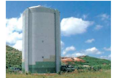
平尾台配水池
