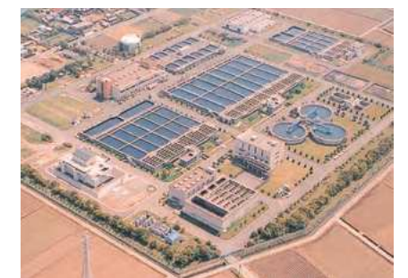
本城浄水場 (昭和58年完成)
