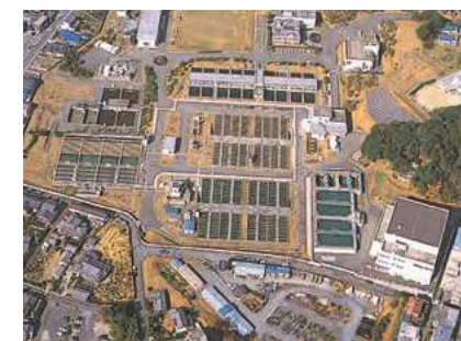
穴生浄水場 (昭和36年完成)
