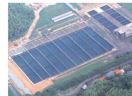
井手浦浄水場 (昭和47年完成)
