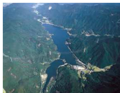
油木貯水池 (昭和46年完成)
