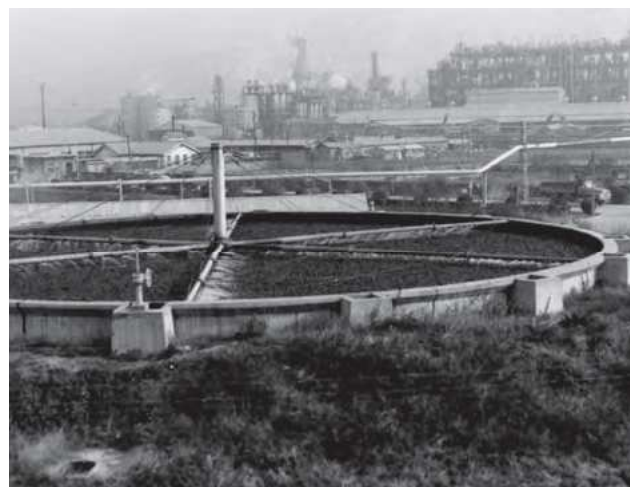
皇后崎下水処理場の散水濾床
