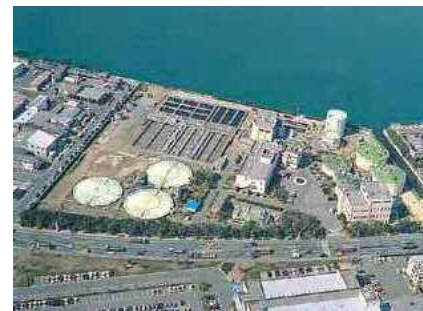
新町浄化センター（門司区）
