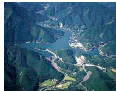
力丸貯水池 (昭和40年完成)
