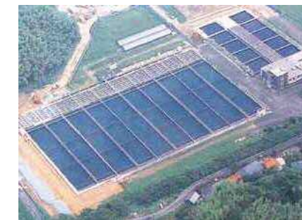
井手浦浄水場 (昭和47年完成)
