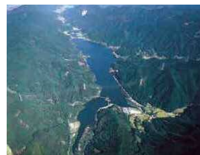
油木貯水池 (昭和46年完成)
