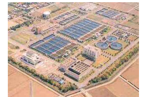
本城浄水場 (昭和58年完成)
