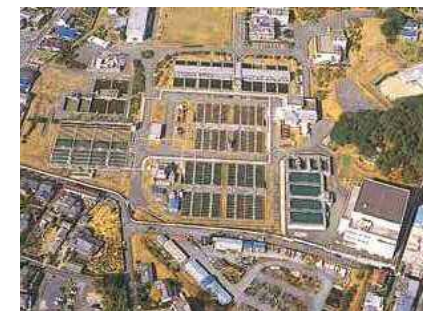
穴生浄水場 (昭和36年完成)
