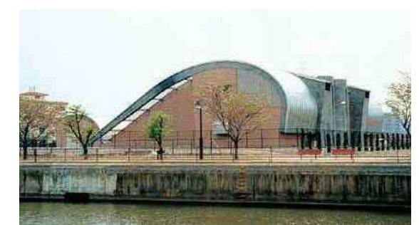
金山川ポンプ場
