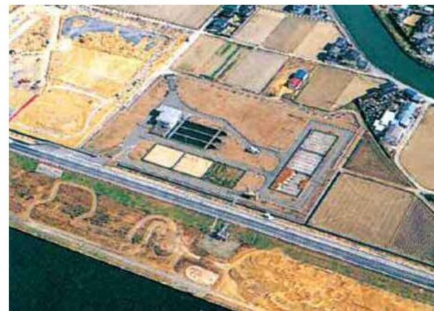
猪熊取水場(昭和58年完成)
