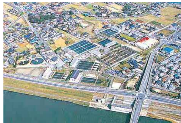
伊佐座取水場(昭和19年完成)
