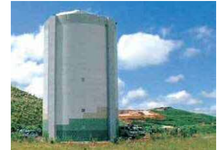
平尾台配水池
