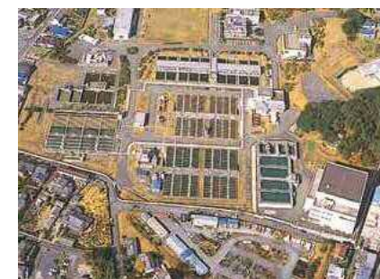
穴生浄水場 (昭和36年完成)
