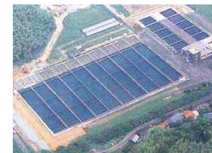
井手浦浄水場 (昭和47年完成)
