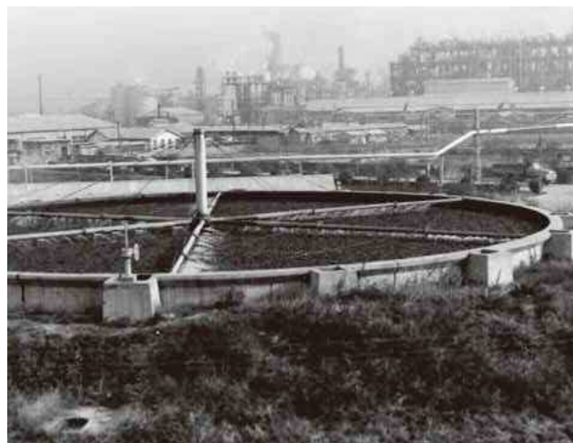
皇后崎下水処理場の散水濾床
