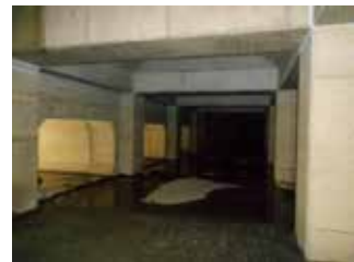
■天籟寺川地下調節池（内部）
