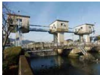
■貫川防潮水門
